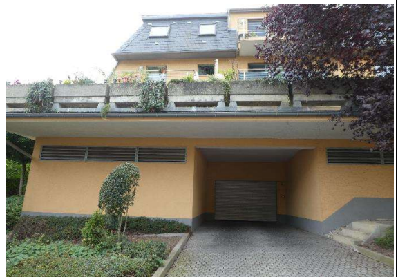
12. Einfahrt zur Tiefgarage
