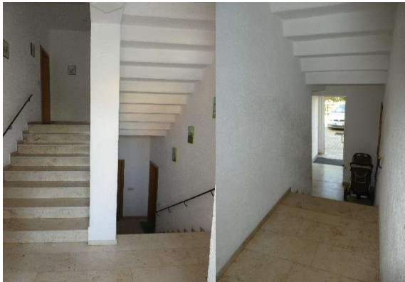
9. Treppenhaus / Eingangsbereich mit Abstellkammer
